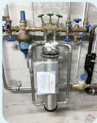
Montage aérien compact sur colliers de serrage.
