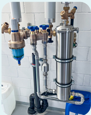
Montage aérien sur colliers de serrage et bride en Y.
