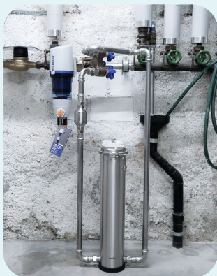
Montage au sol sur une bride en Y compacte.
