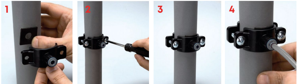
Anschlussposition der Abwasserschelle.
